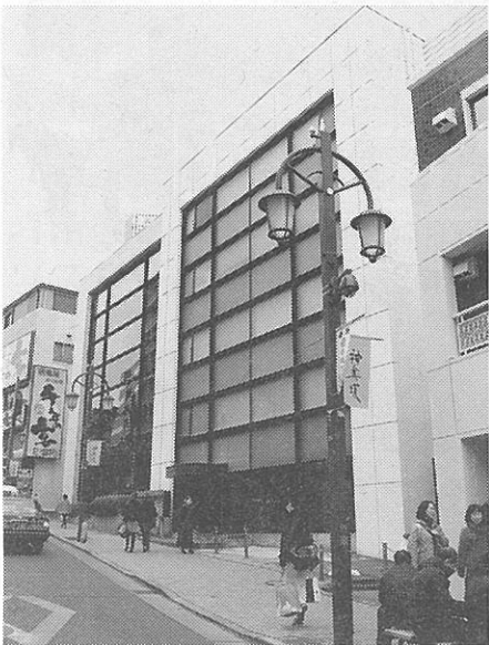
1961 年、神楽坂に本社ビルを建設、1983 年に現在の本社ビルと音楽の友ホールを落成した。
